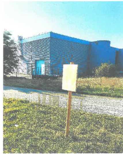
rond-point Porte de France
